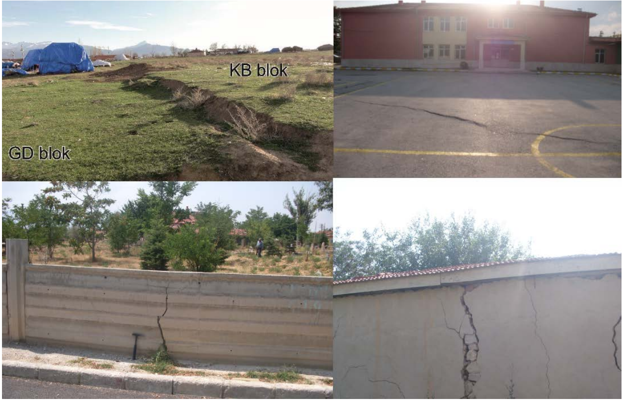
Şekil 3. YüzeY deformasyonları ve hasarlı binalar
